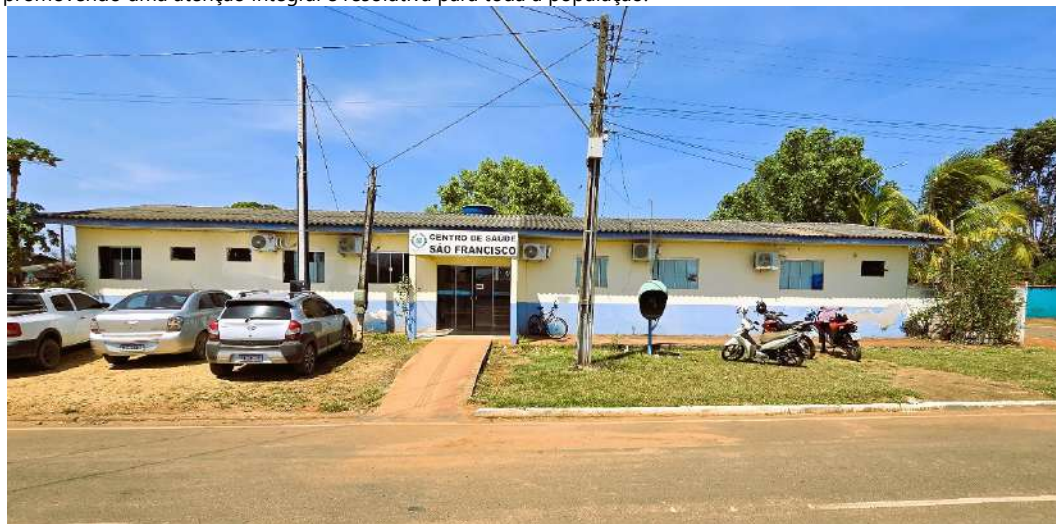
Sede da Coordenação da Atenção Básica de Saúde do Município
